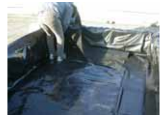
図4 耐根フィルムの設置
