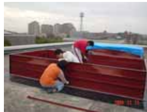
図3 土台枠の組み立て
